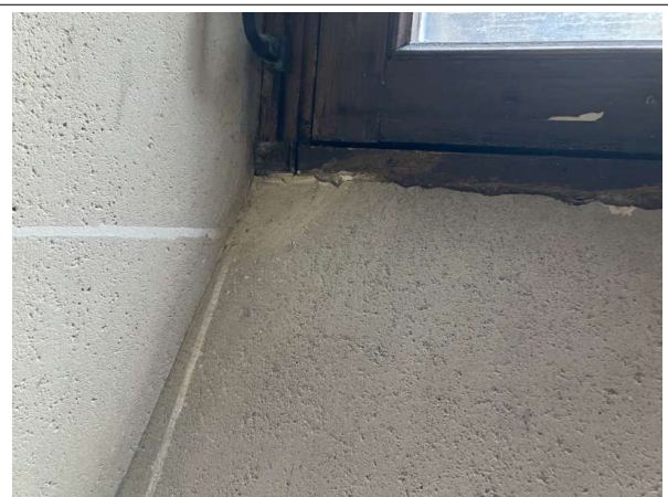
Prélèvement - P193 : Patio 1 / RdC / Façade Nord / Circulation - Parement- (Absence d'amiante)
