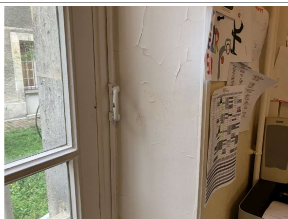
Prélèvement - P4 : Patio 1 / RdC / Façade Est / Local 47 - Enduit- (Absence d'amiante)
