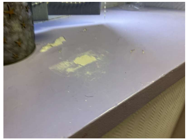
Prélèvement - P74 : Patio 1 / RdC / Façade Ouest / Local 13/15 - Enduit- (Absence d'amiante)
