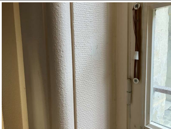
Prélèvement - P81 : Patio 1 / RdC / Façade Ouest / Local 16 - Enduit- (Absence d'amiante)
