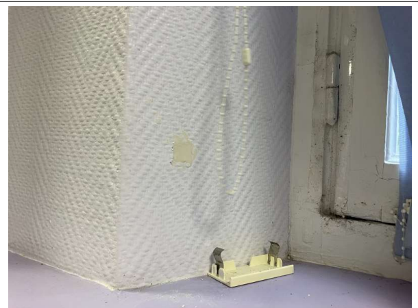
Prélèvement - P72 : Patio 1 / RdC / Façade Ouest / Local 13/15 - Enduit- (Absence d'amiante)
