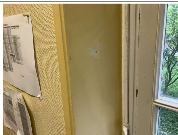
Prélèvement - P10 : Patio 1 / RdC / Façade Est / Local 46 - Enduit- (Absence d'amiante)
