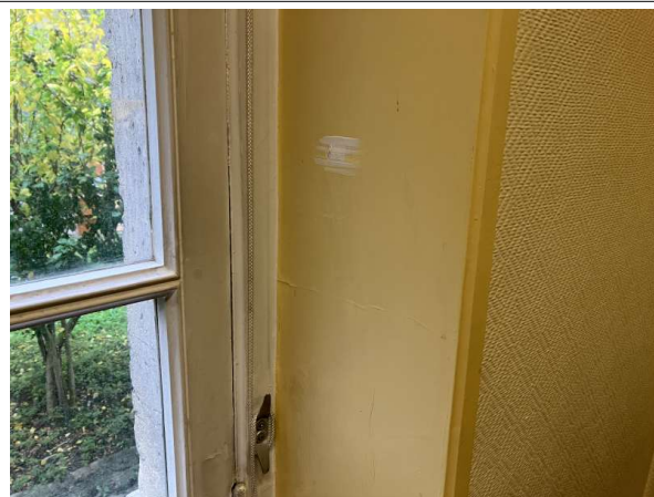
Prélèvement - P8 : Patio 1 / RdC / Façade Est / Local 46 - Enduit- (Absence d'amiante)
