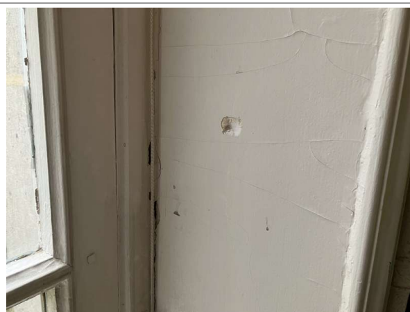
Prélèvement - P12 : Patio 1 / RdC / Façade Est / Local 45 - Enduit- (Absence d'amiante)
