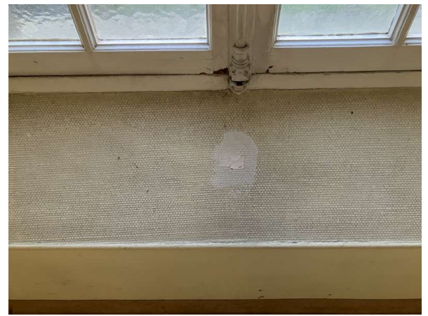
Prélèvement - P202 : Patio 1 / RdC / Façade Sud / Circulation - Enduit- (Absence d'amiante)
