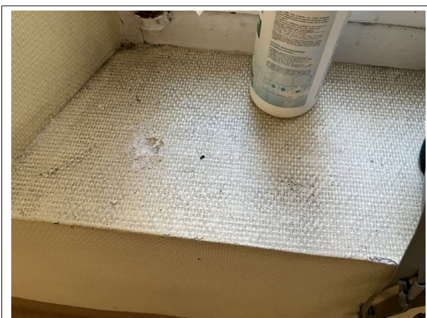
Prélèvement - P198 : Patio 1 / RdC / Façade Sud / Circulation - Enduit- (Absence d'amiante)
