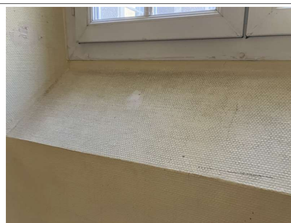
Prélèvement - P210 : Patio 1 / RdC / Façade Sud / Circulation - Enduit- (Absence d'amiante)
