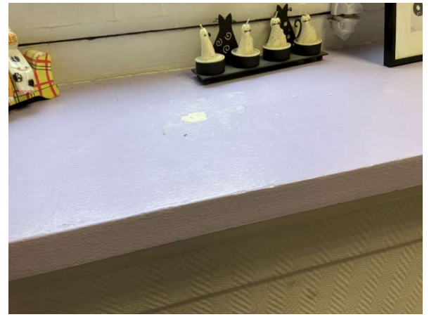
Prélèvement - P68 : Patio 1 / RdC / Façade Ouest / Local 13/15 - Enduit- (Absence d'amiante)
