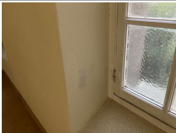
Prélèvement - P203 : Patio 1 / RdC / Façade Sud / Circulation - Enduit- (Absence d'amiante)
