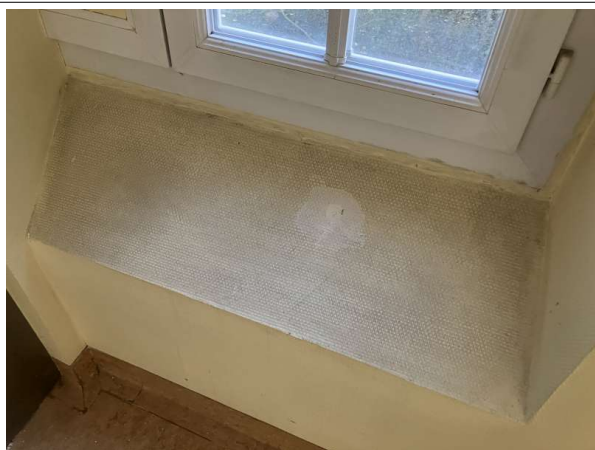
Prélèvement - P206 : Patio 1 / RdC / Façade Sud / Circulation - Enduit- (Absence d'amiante)
