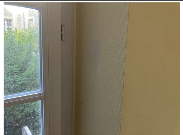
Prélèvement - P205 : Patio 1 / RdC / Façade Sud / Circulation - Enduit- (Absence d'amiante)
