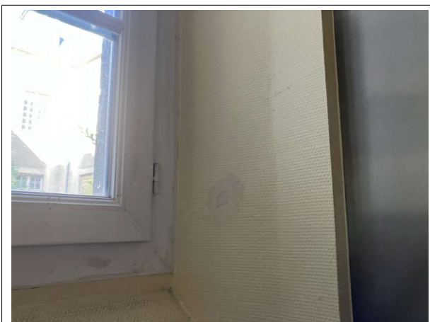
Prélèvement - P209 : Patio 1 / RdC / Façade Sud / Circulation - Enduit- (Absence d'amiante)
