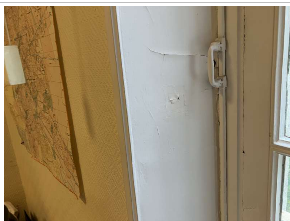
Prélèvement - P6 : Patio 1 / RdC / Façade Est / Local 47 - Enduit- (Absence d'amiante)
