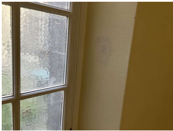
Prélèvement - P201 : Patio 1 / RdC / Façade Sud / Circulation - Enduit- (Absence d'amiante)
