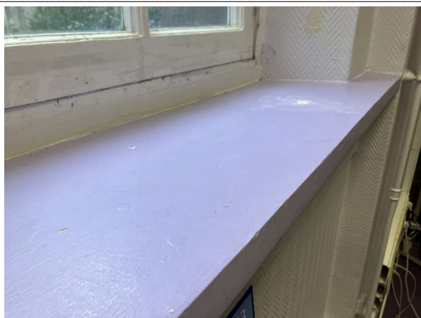
Prélèvement - P71 : Patio 1 / RdC / Façade Ouest / Local 13/15 - Enduit- (Absence d'amiante)
