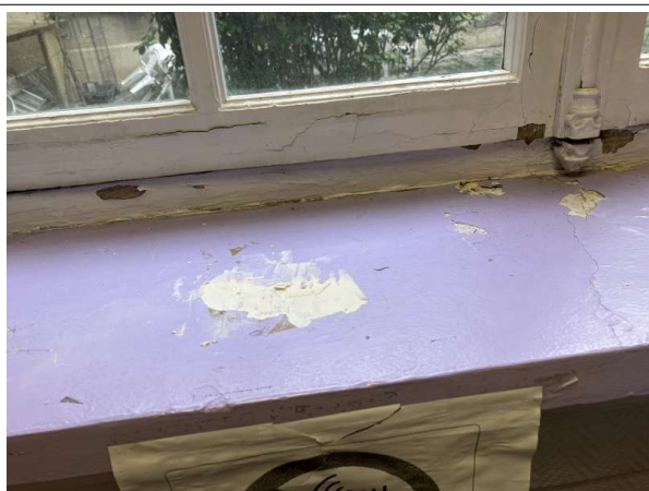
Prélèvement - P77 : Patio 1 / RdC / Façade Ouest / Local 13/15 - Enduit- (Absence d'amiante)
