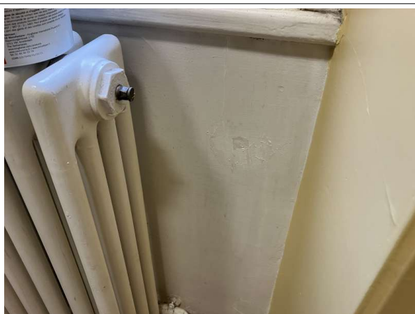
Prélèvement - P9 : Patio 1 / RdC / Façade Est / Local 46 - Enduit- (Absence d'amiante)
