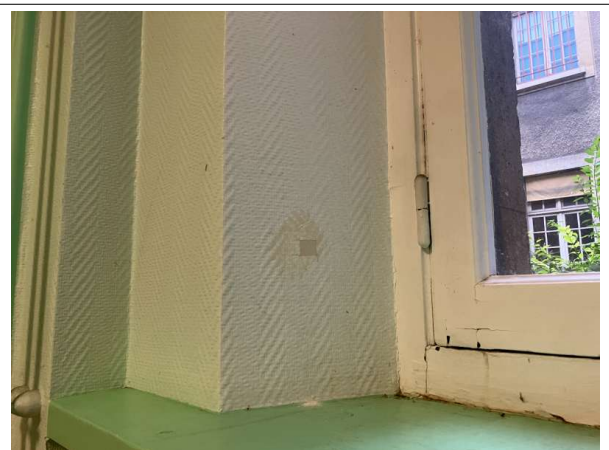
Prélèvement - P66 : Patio 1 / RdC / Façade Ouest / Local 11 - Enduit- (Absence d'amiante)
