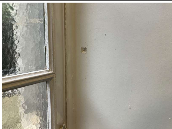
Prélèvement - P1 : Patio 1 / RdC / Façade Est / Local 48 - Enduit- (Absence d'amiante)
