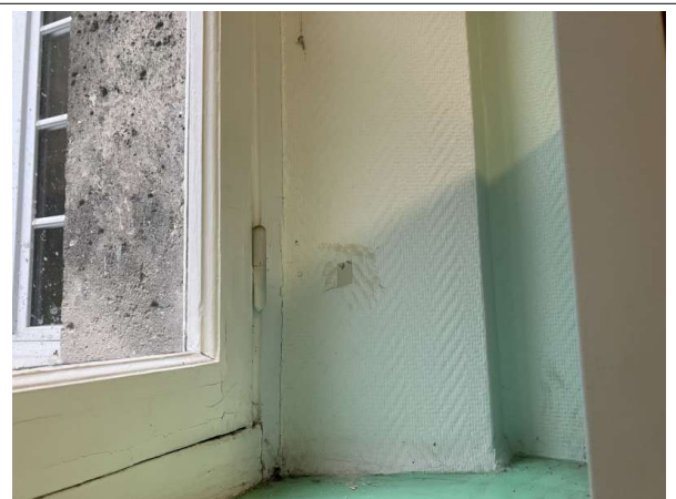
Prélèvement - P64 : Patio 1 / RdC / Façade Ouest / Local 11 - Enduit- (Absence d'amiante)
