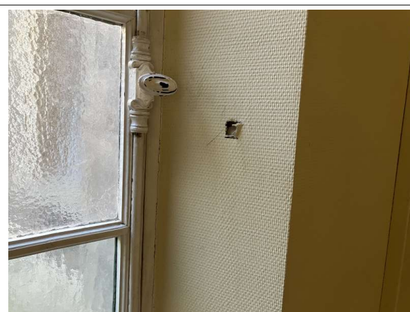
Prélèvement - P197 : Patio 1 / RdC / Façade Sud / Circulation - Enduit- (Absence d'amiante)
