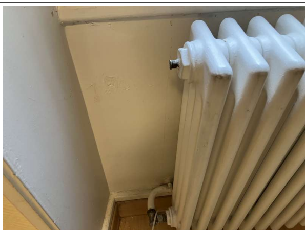
Prélèvement - P5 : Patio 1 / RdC / Façade Est / Local 47 - Enduit- (Absence d'amiante)
